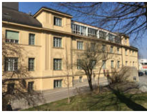
Abb. 45 – Krankenhaus Klosterneuburg, Foto: AStKI
